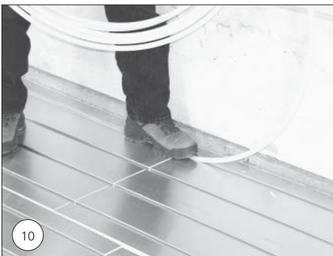
10 Rørene lægges i henhold til udlægningsmønstret. Vær opmærksom på at rørene trykkes helt ned i sporet, så de ikke ligger over selve pladen. Dette er for at undgå støj og lydproblemer specielt hvor der skal udlægges flydende overgulv. I vendepladerne skal rørene lægges så tæt på indercirklen som muligt for at sikre at rørene har udvidelsesmuligheder.
