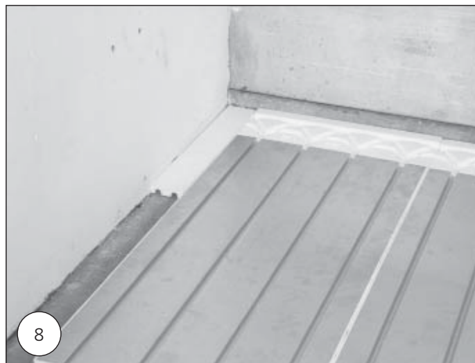
8 Fortsæt med udlægningen af pladerne. Ved tomrum op mod vægge som er mindre end 100 mm i bredden kan fremføringsplader bruges til at fylde tomrummet.
